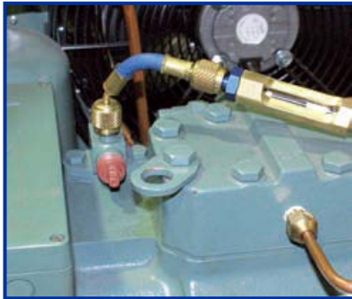
Slika 15: Test ulja na usisnoj liniji kompresora
