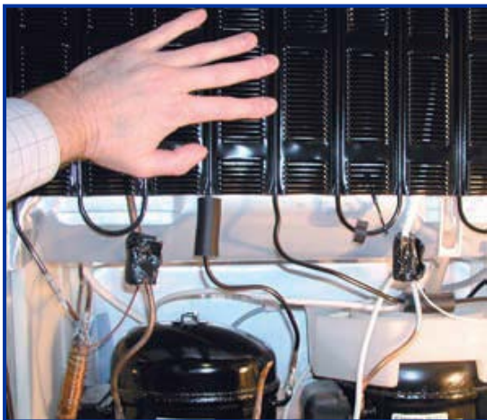
Slika 2: Izgled rashladnog kola
