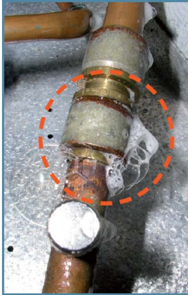
Slika 23a: Primjer spoja koji curi (obratite pažnju na mjehuriće)
