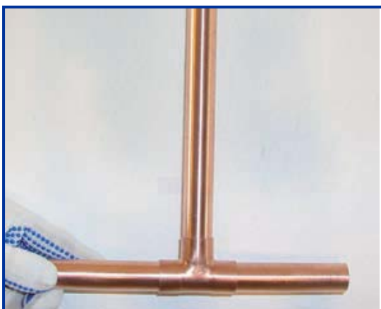
Slika 6: Spajanje cijevi i spojnice
