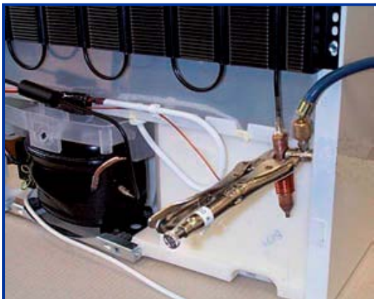
Slika 8: Postavljanje dodatnih kliješta sa ubodnim priključkom
