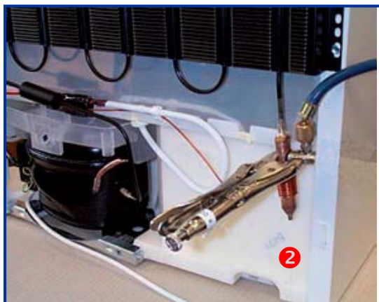
Slika 8: Postavljanje dodatnih kliješta sa ubodnim priključkom
