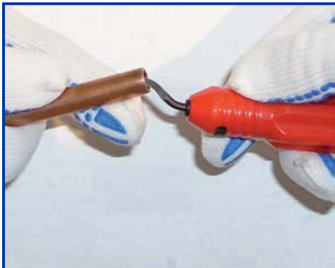
Slika 2: Obrada ivica cijevi
