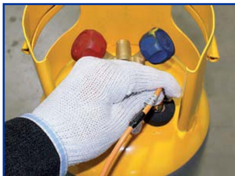
Slika 7: Povezivanje priključka za zaštitu od prepunjavanja na priključak na cilindru za prikupljanje
